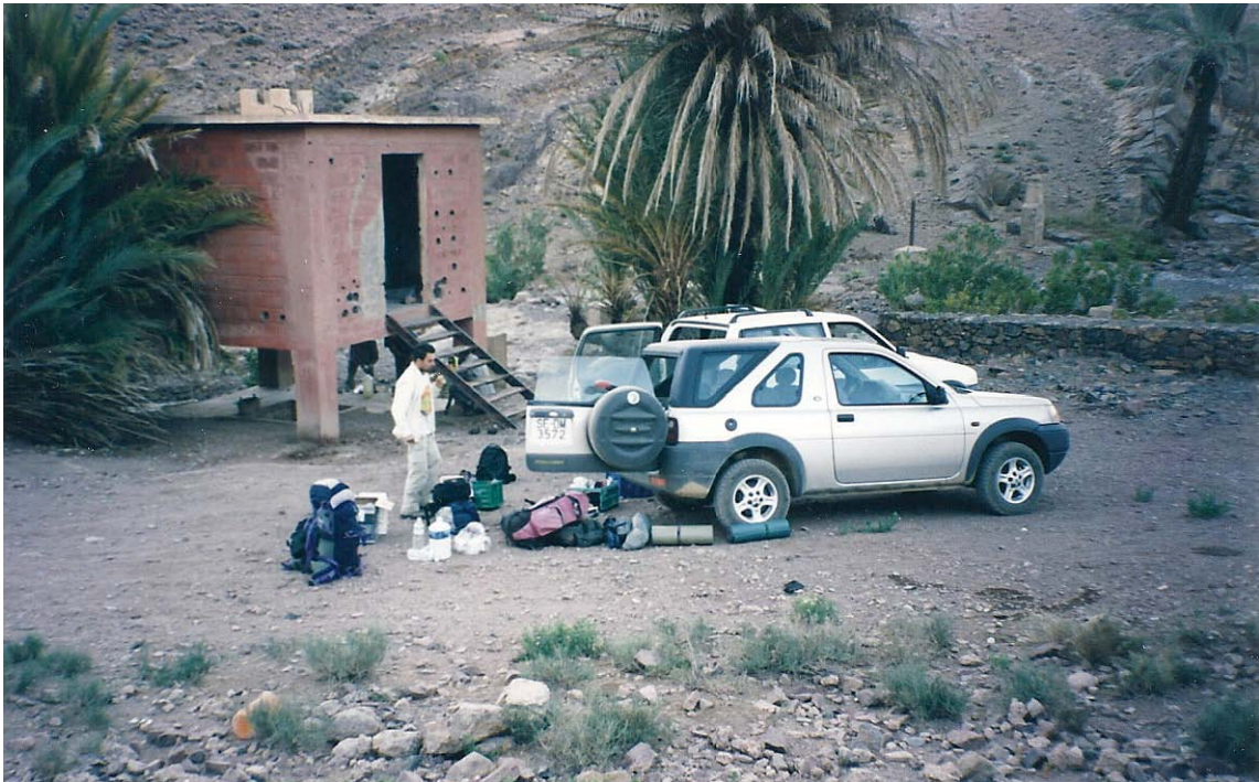
Casa de bombas abandonada
